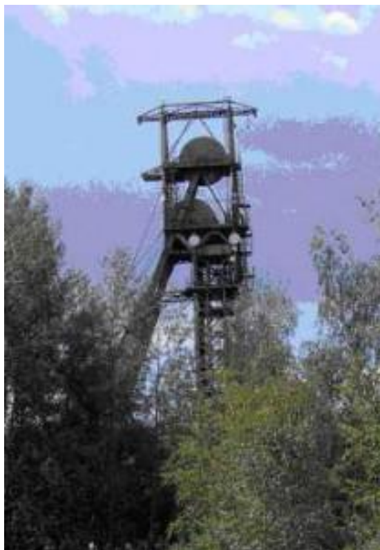
Obrázek Těžní věž – první využití parního stroje bylo právě v hornictví
