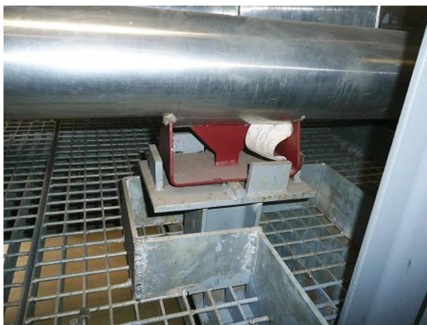
obr. 5.5 Směrová zarážka ve směru obou os s vůlemi
