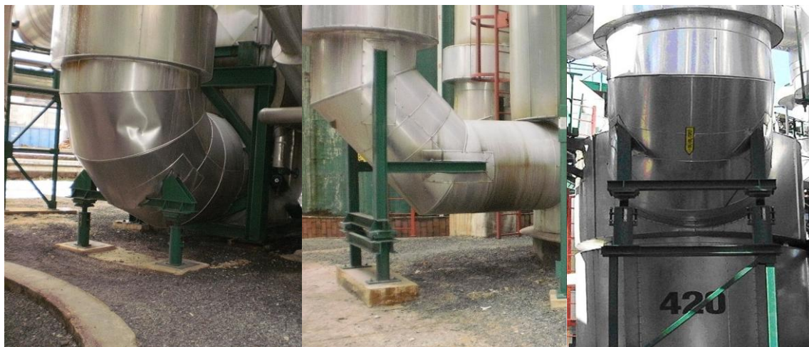
obr. 5.26 Uložení duktů – příklad 1, 2, 3
