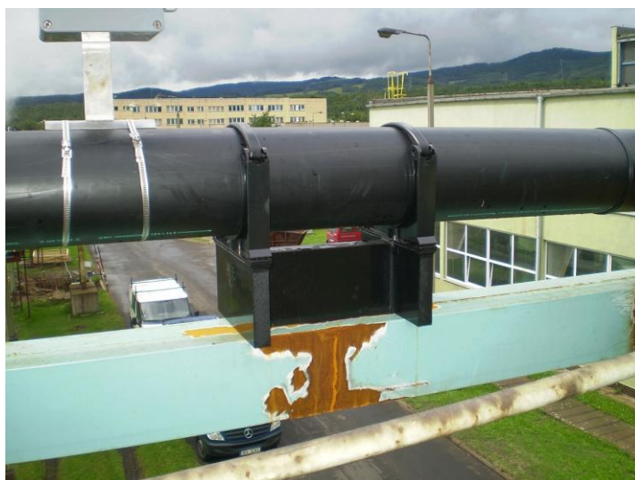
obr. 6.4. Improvizovaná kluzná podpěra pro plastové potrubí
