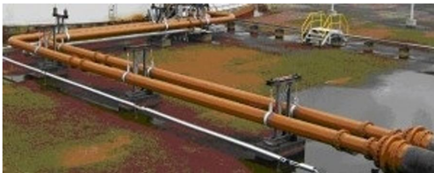
obr. 5.16 Tuhé závěsy na vodorovném potrubí
