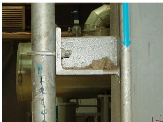
obr. 5.11 Provedení směrové zarážky pomocí kulatého třmenu - foto
