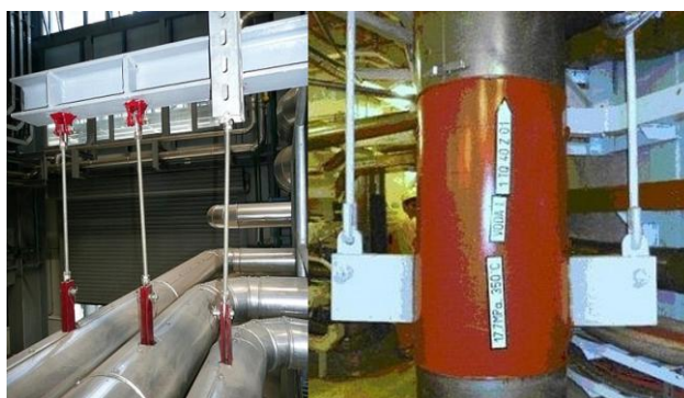
obr. 5.15 Tuhé závěsy vodorovného a svislého potrubí
