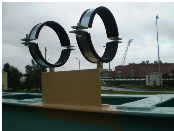
obr. 6.3 Improvizovaný pevný bod pro plastové potrubí
