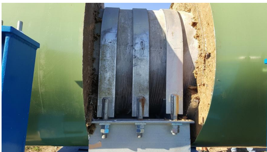
obr. 5.2 Provedení kotvení - foto
