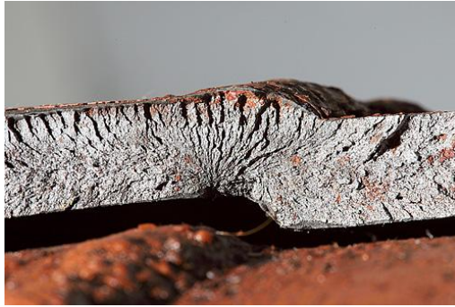
Obr.9. Detail křehkého lomu ve stěně tlakové nádoby. Je zde náhlý přechod v průměru tlakové nádoby a z toho vyplývající místo iniciace lomu
